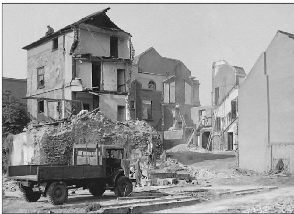
Bombeskader – fremdeles svært synlig i 1953
